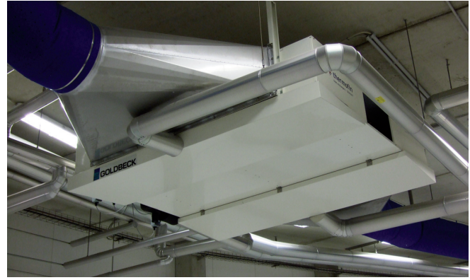
Aggregat Grasso SP Duo mit zwei Schraubenverdichtern und insgesamt 620 kW Kälteleistung (Foto li.: Anderten Kälte + Klima GmbH). 19 Spezialluftkühler vom Typ TGDN.R 050.1-G-2-7-SA sind über der Laufstrecke verteilt (Foto re.: Thermofin)
