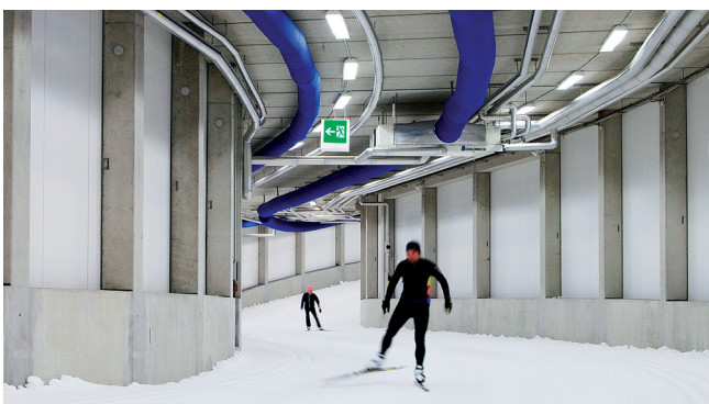
Die zugfreie Luftverteilung erfolgt über Textilschläuche (Foto li.: Oberhof Sportstätten GmbH). Vier Schneekanonen sorgen für die Beschneigung (Foto re.: Anderten Kälte + Klima GmbH)
