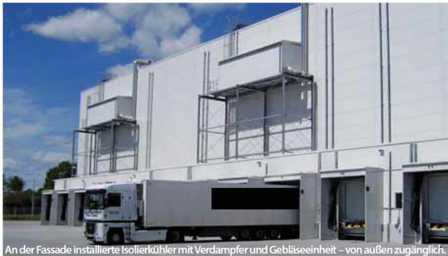
An der Fassade installierte Isolierkühler mit Verdampfer und Gebläseeinheit – von außen zugänglich.
