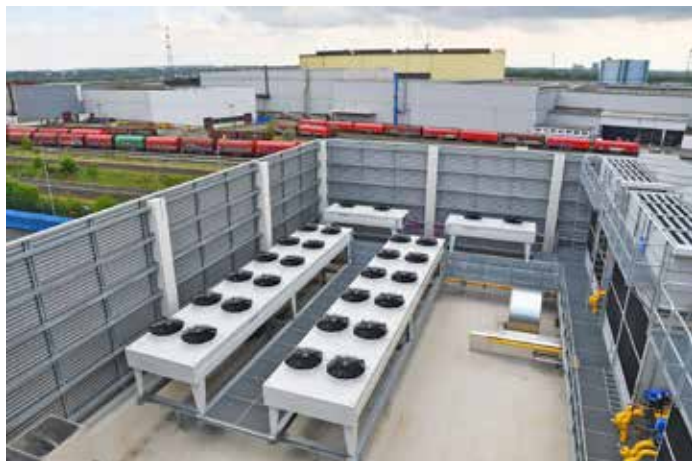
thermofin-Verflüssiger („TACH“) und -Rückkühler („TDH“)
