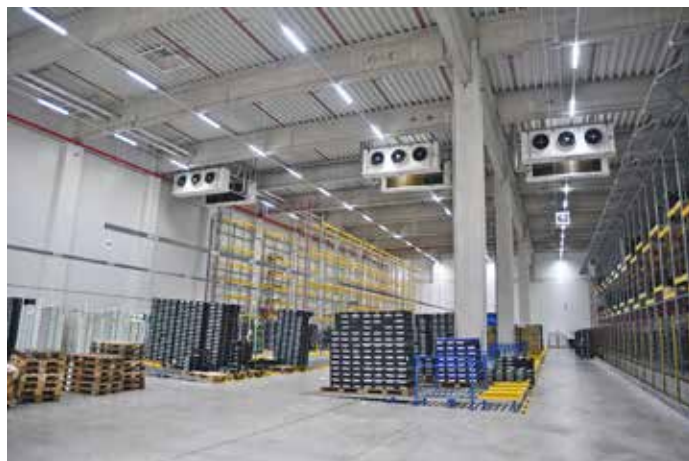
thermofin-Deckenverdampfer vom Typ „TAL“ (NH 3 -DX) im Wareneingang und Lager
