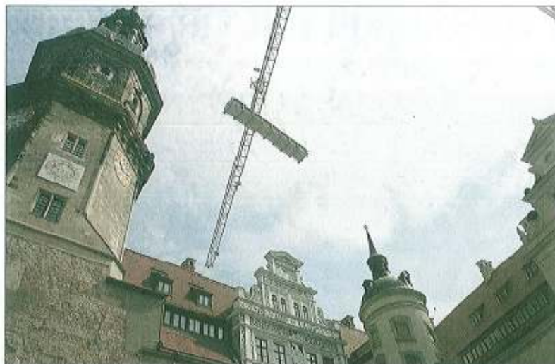
Mittels eines Krans sind die Thermofin-Wärmetauscher auf das Dach des Dresdner Schlosses gehievt worden. Ein Gerät wiegt stolze 1600 Kilogramm.
