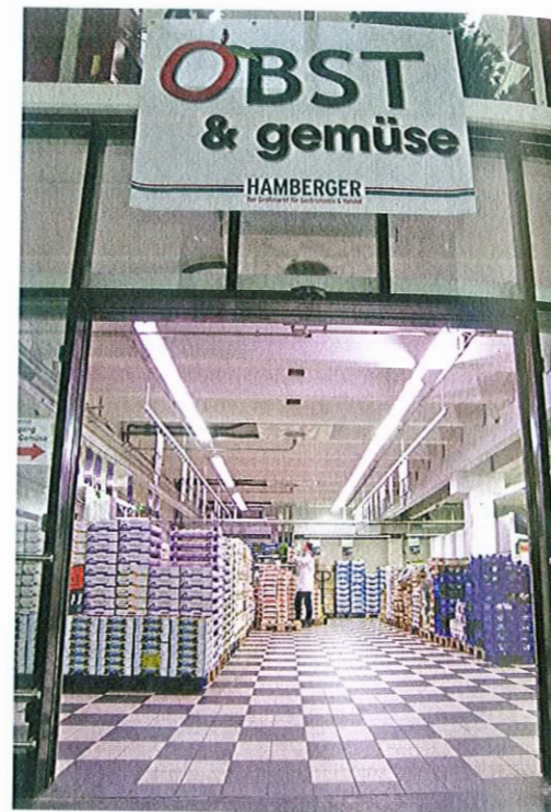
Bei der Hamberger Großmarkt GmbH in München gab es eine schier unlösbare Aufgabe zu knacken: Trotz geringer Raumhöhe zugerscheinungsfreie Kühlung mit niedrigem Schallpegel
