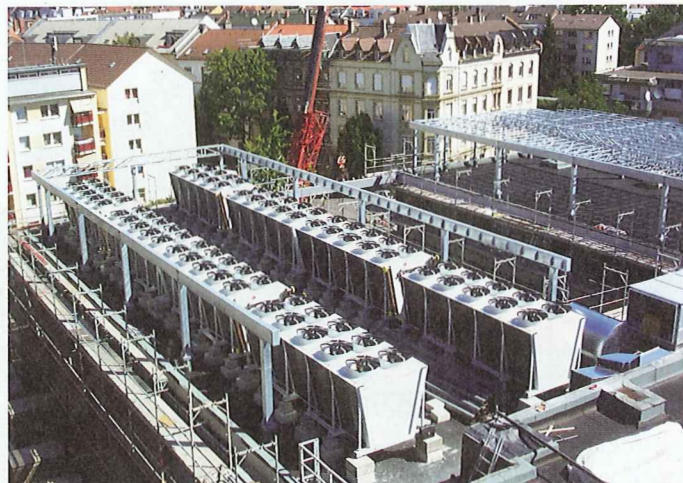
Der Neubau der Zentrale des Deutschen Wetterdienstes (DWD) liegt mitten in einem Wohngebiet in Offenbach, dementsprechend mussten schallschutztechnische Anforderungen beachtet werden
