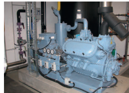
GEA Grasso-Kolbenverdichter, Typ RCU 610, 156 kW
