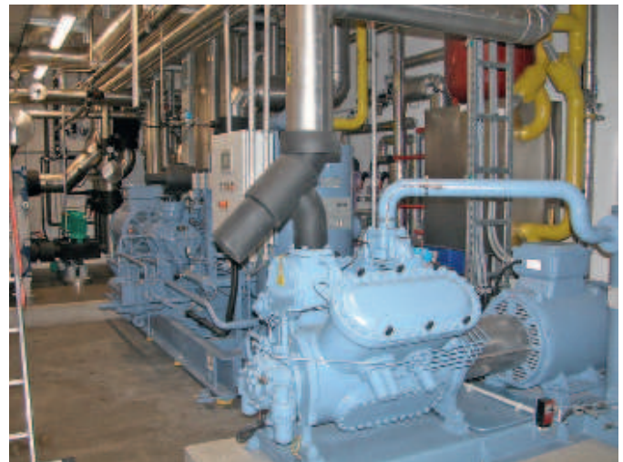
Blick in den Maschinenraum: Im Vordergrund der Hubkolbenverdichter, dahinter die beiden Schraubenverdichter (DuoPak) auf einem Rahmen.
