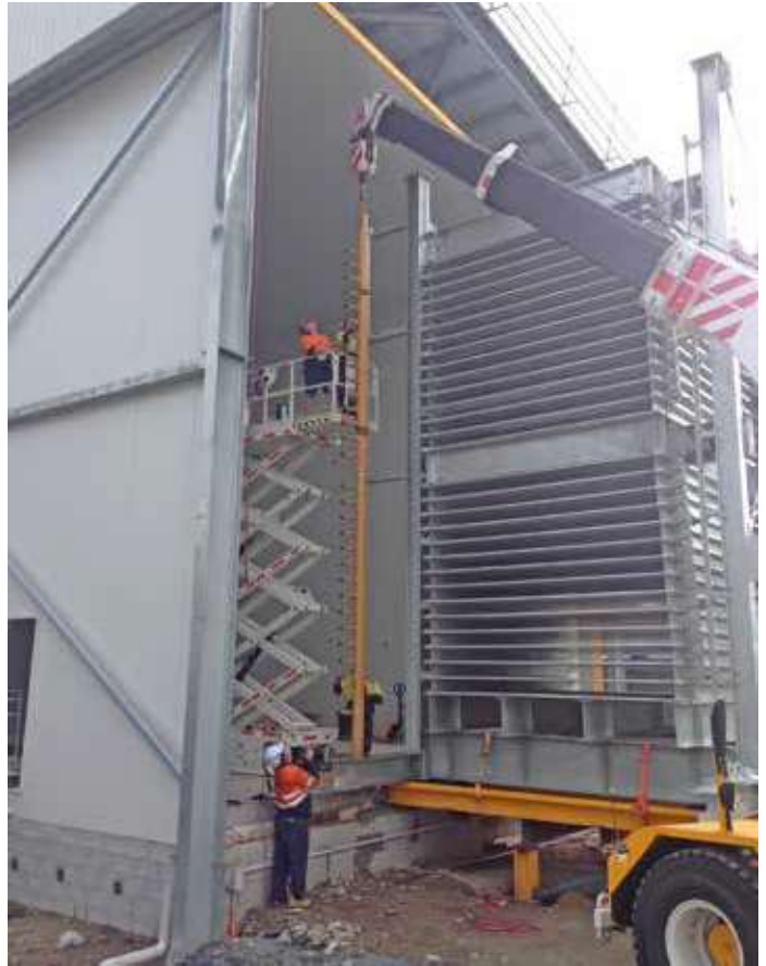
Bild 12: Großplattenfroster während der Installation
