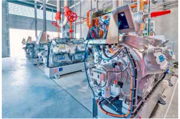
Bild 8: Maschinenraum während des Baus
