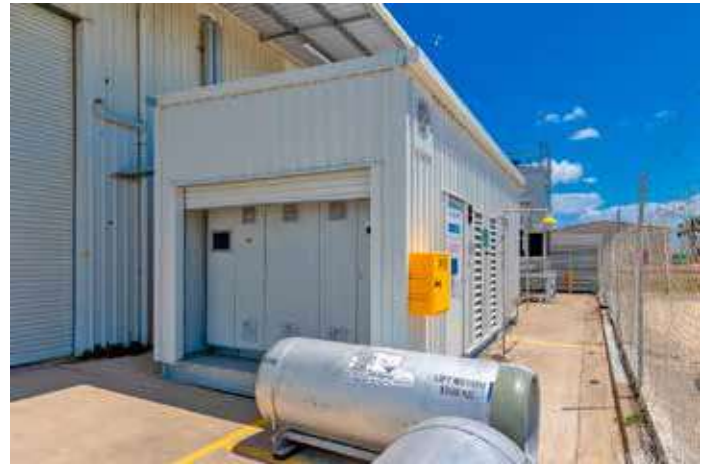
Bild 9b: ... und während der Fertigstellung – TK/NK-Leistungen 45/49 kW
