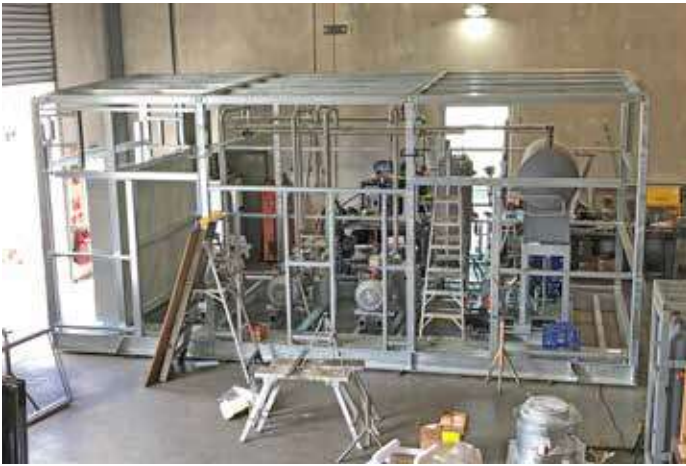
Bild 9a: „ScanPAC“-Maschinenraum während der Bauzeit ...
