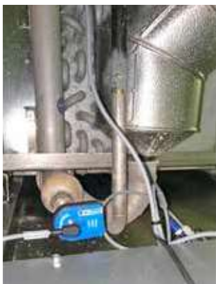
Bild 5: Typische Qualitätssensor-anordnung
