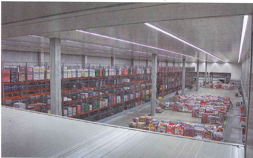
Blick in das „WA-Lager Frische“ und Bereitstellung vom Ansaug
