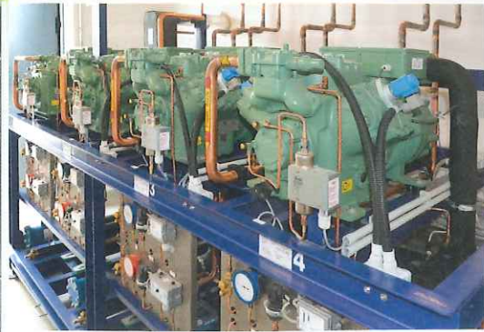
Abb. 5: Die vier R1270-Kälteerzeuger im abgegrenzten Maschinenraum mit je 11 kg Füllmenge
